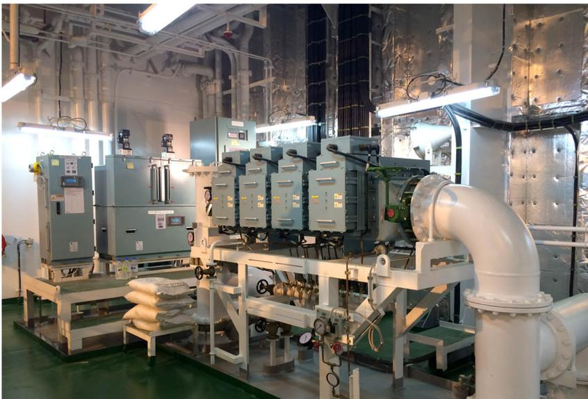
본 특허는 2011년 등록된 것으로, 선종 및 제품의 처리 방식에 상관없이 선박 내 적소에 설치할 수 있는 선박 구조 솔루션을 제공하고 있다. 본 솔루션은 직/간접식 전기분해방식 제품의 설치 위치와 UV 및 전기분해식 제품의 배관 구조에 해당하는 전반적인 설치 솔루션으로, BWMS를 선박 후방의 조타기실에 설치하도록 하여, 선박 내의 공간을 유효하게 활용한 것이 특징이다. 때문에 선체 구조나 선형을 크게 변경하지 않아도 되는 장점을 가지고 있으며, 이것은 또한 신조선 및 기존선을 가리지 않고 쉽게 설치할 수 있다는 것을 의미하기도 한다.
